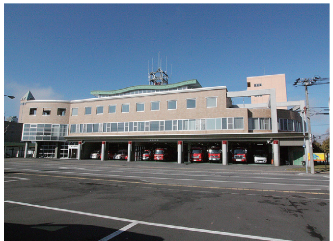
消防本部のある、美瑛消防署庁舎
